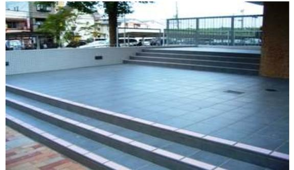
段鼻施工・厚さ 2mm 骨材色 HP-02
