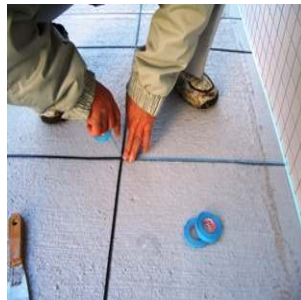
②目地棒 マスキングテープ貼り
