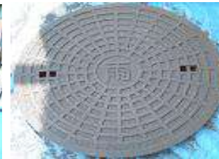
⑦仕上げ塗り 上塗り乾燥後、 専用プライマーを上塗り
