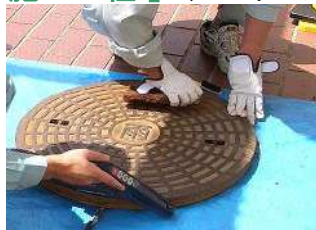
①養生・清掃(乾式) サビ、汚れ等の除去。
