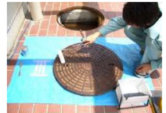
④下塗り 攪拌後のシグマ01を塗布。
