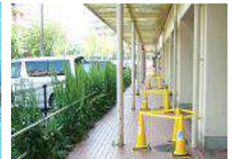
⑧完了・乾燥 乾燥24時間。 80℃以下で強制乾燥可能。
