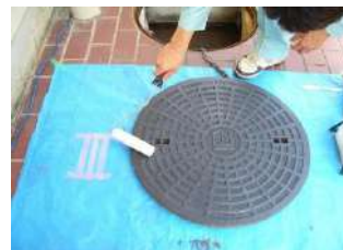
⑥上塗り 余分な骨材を除去後、 シグマ01を上塗り。
