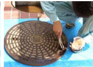
③プライマー塗布 専用プライマー塗布。
