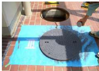
⑤骨材散布 骨材を均一に散布。 品番TKB・1kg/m 2 。
