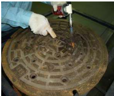
①アスファルト等の除去
